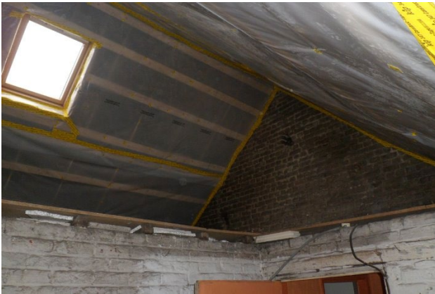
Dampoort KnapT OP project ~30.000€/house
